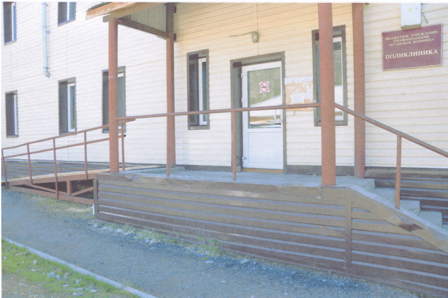
Площадка перед входом
